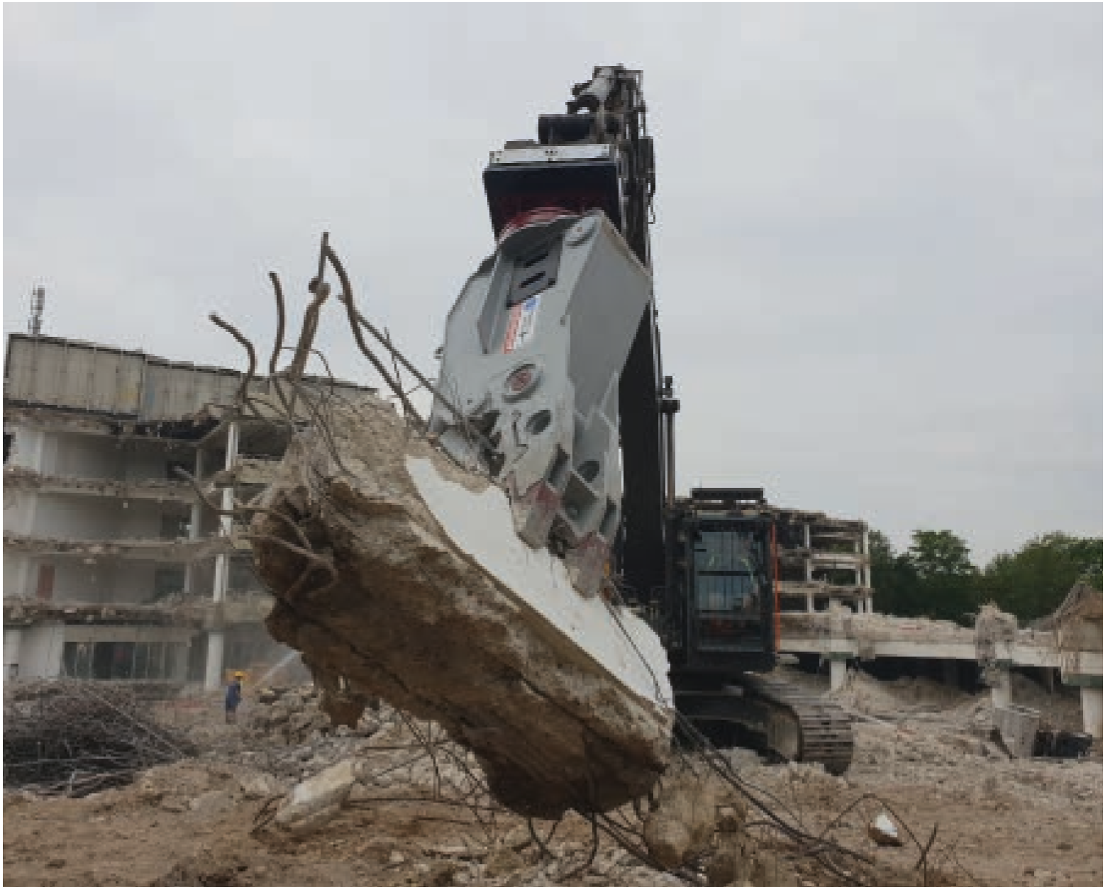
De DLP-24 is inzetbaar bij primaire en secundaire sloop en geschikt voor machines van 18-25 ton.
