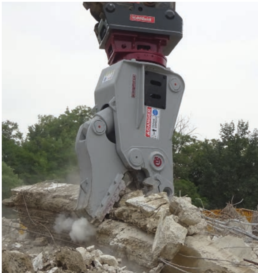
Het is een compleet nieuw concept maar wel volgens de Demarec filosofie dus met verwisselbare slijtdelen.
